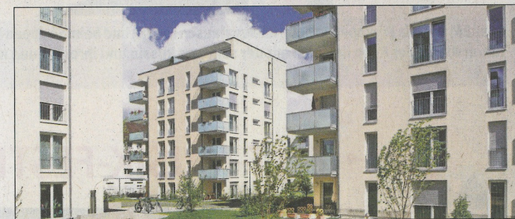
Dreimal genossenschaftliches Wohnen: Wohnungen der Heimbau Breisgau in der Stefan-Meier-Straße, Neubauten der Familienheim Freiburg in der Quäker- und des Bauvereins Breisgau in der Rastatter Straße (von oben n. unten).
